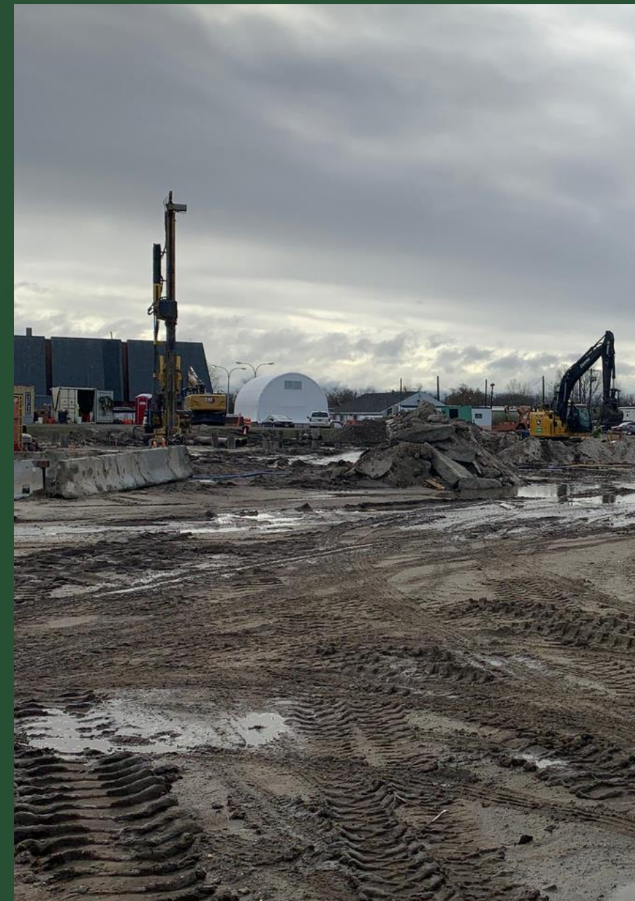
Mini Pile installation at CC1, April 2022
