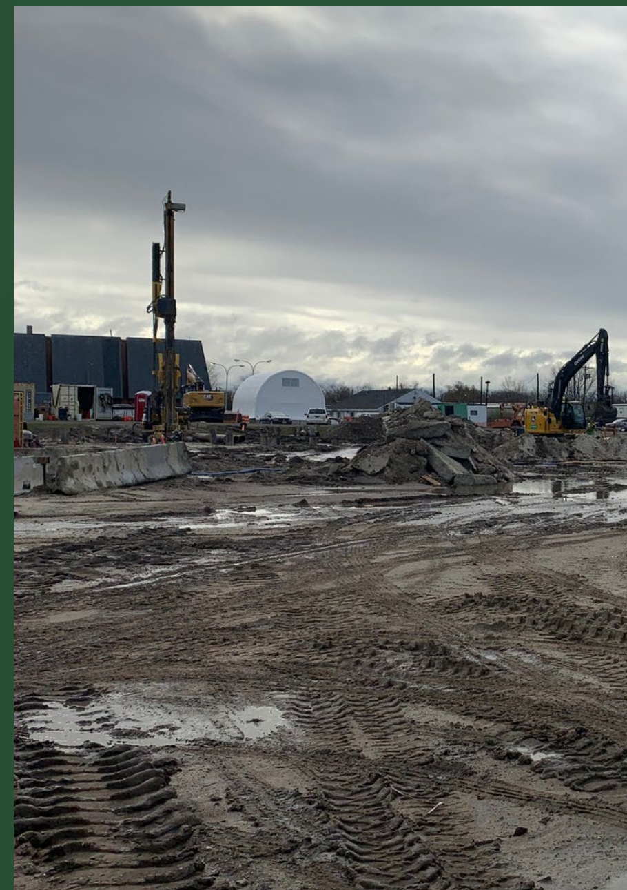
Mini Pile installation at CC1, April 2022
