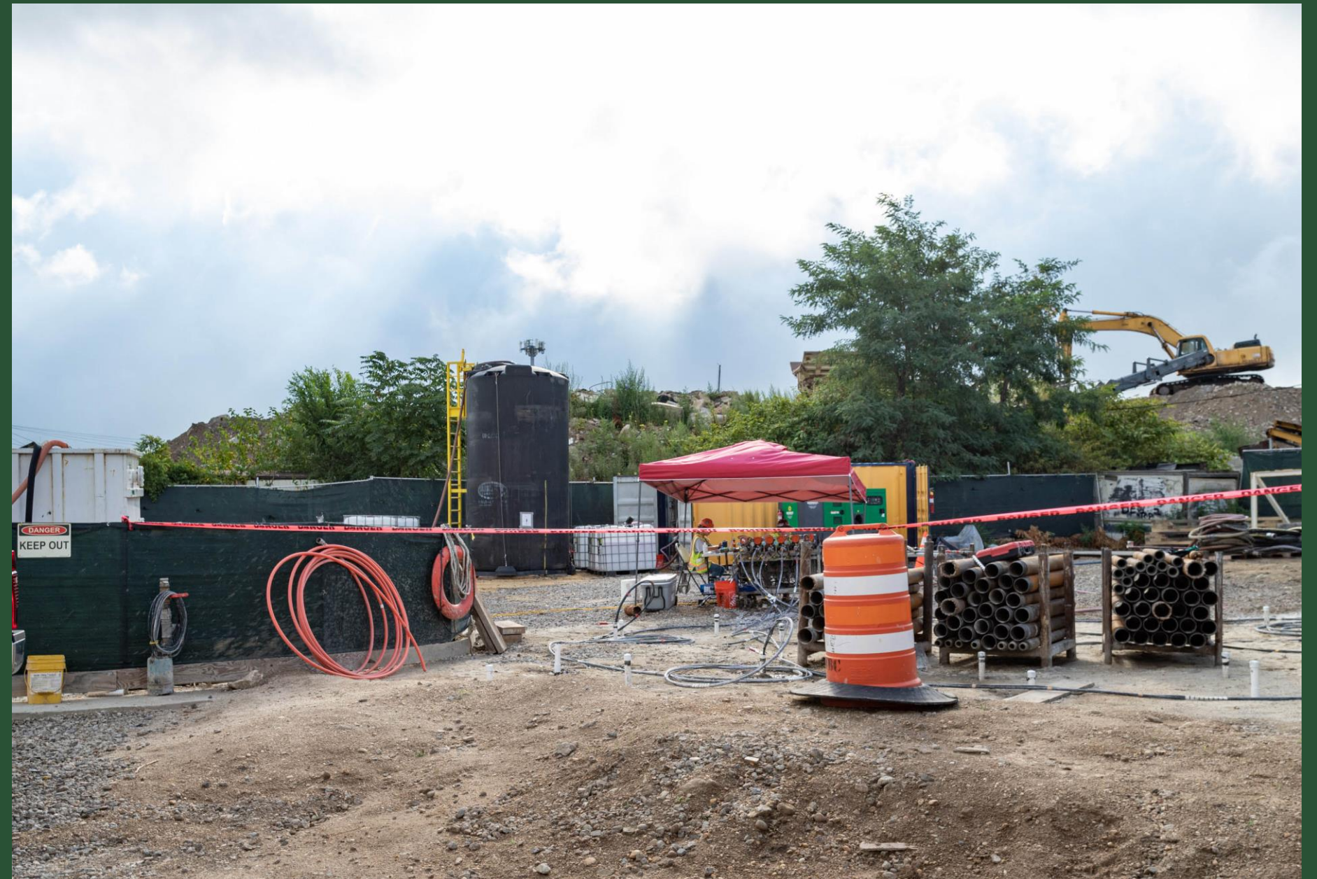
BP3 Construction Site (August 2022)
