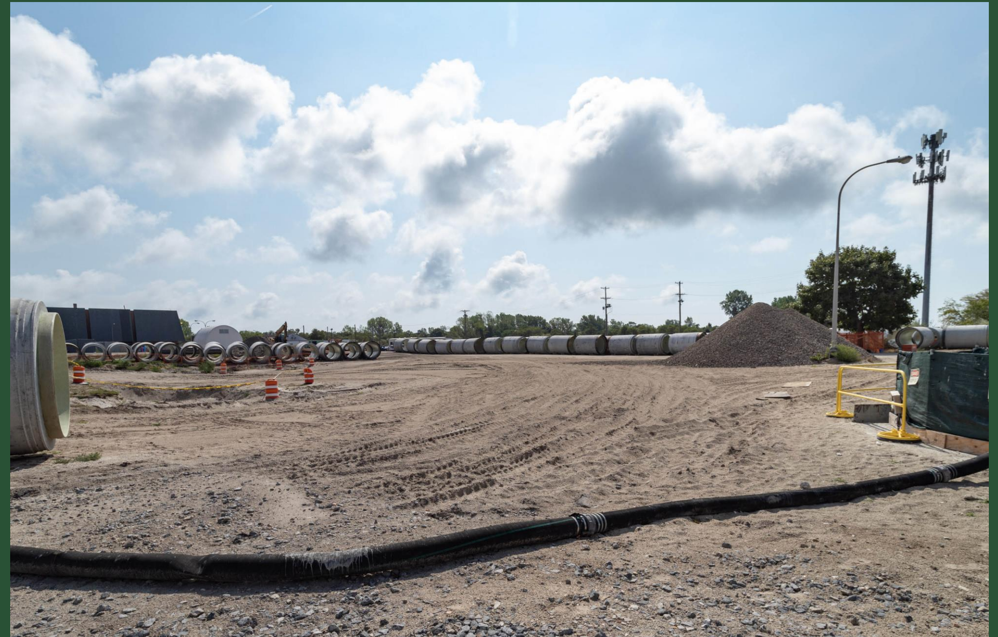
Construction Site at CC1 (August 2022)
