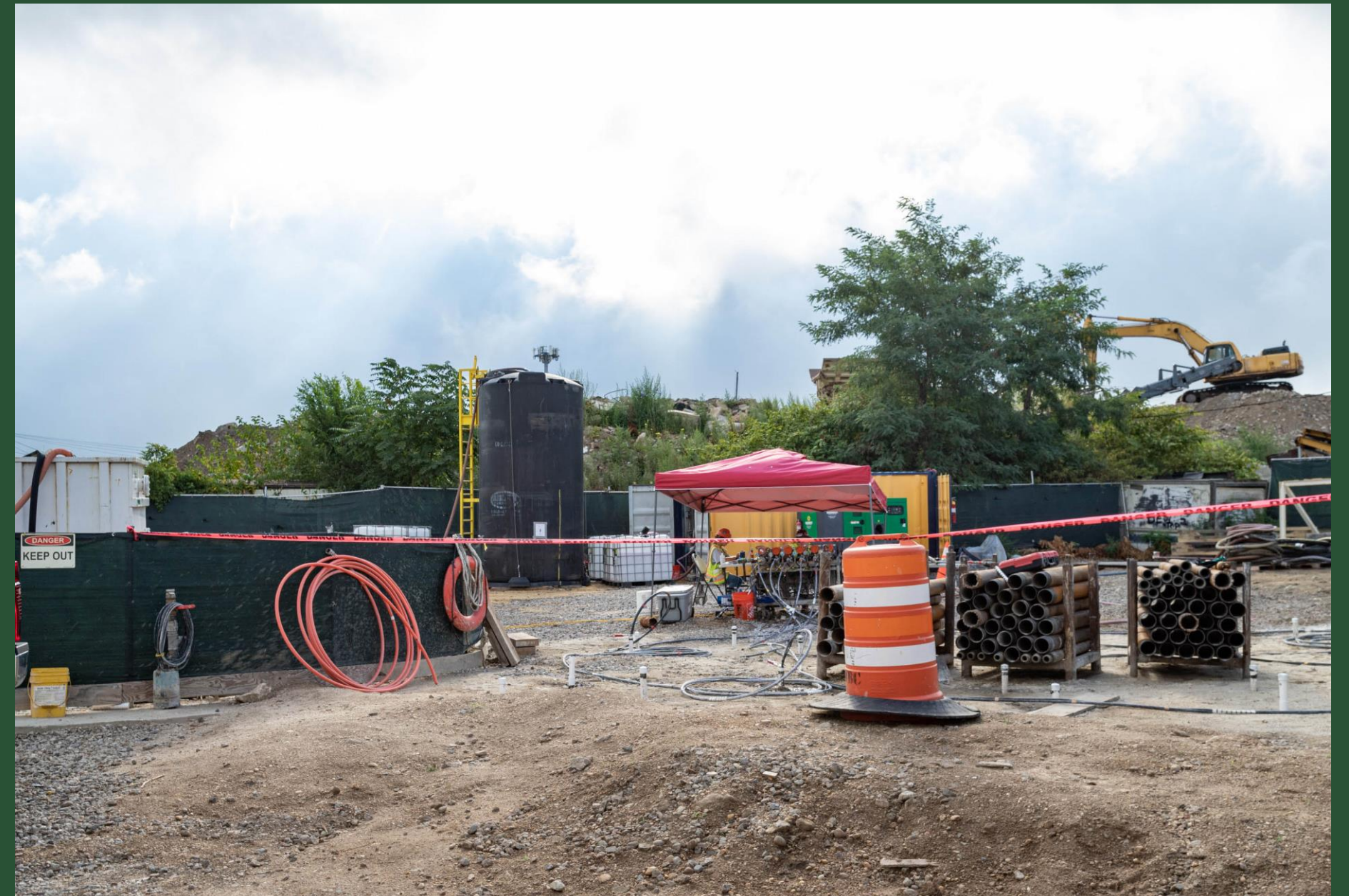
BP3 Construction Site (August 2022)
