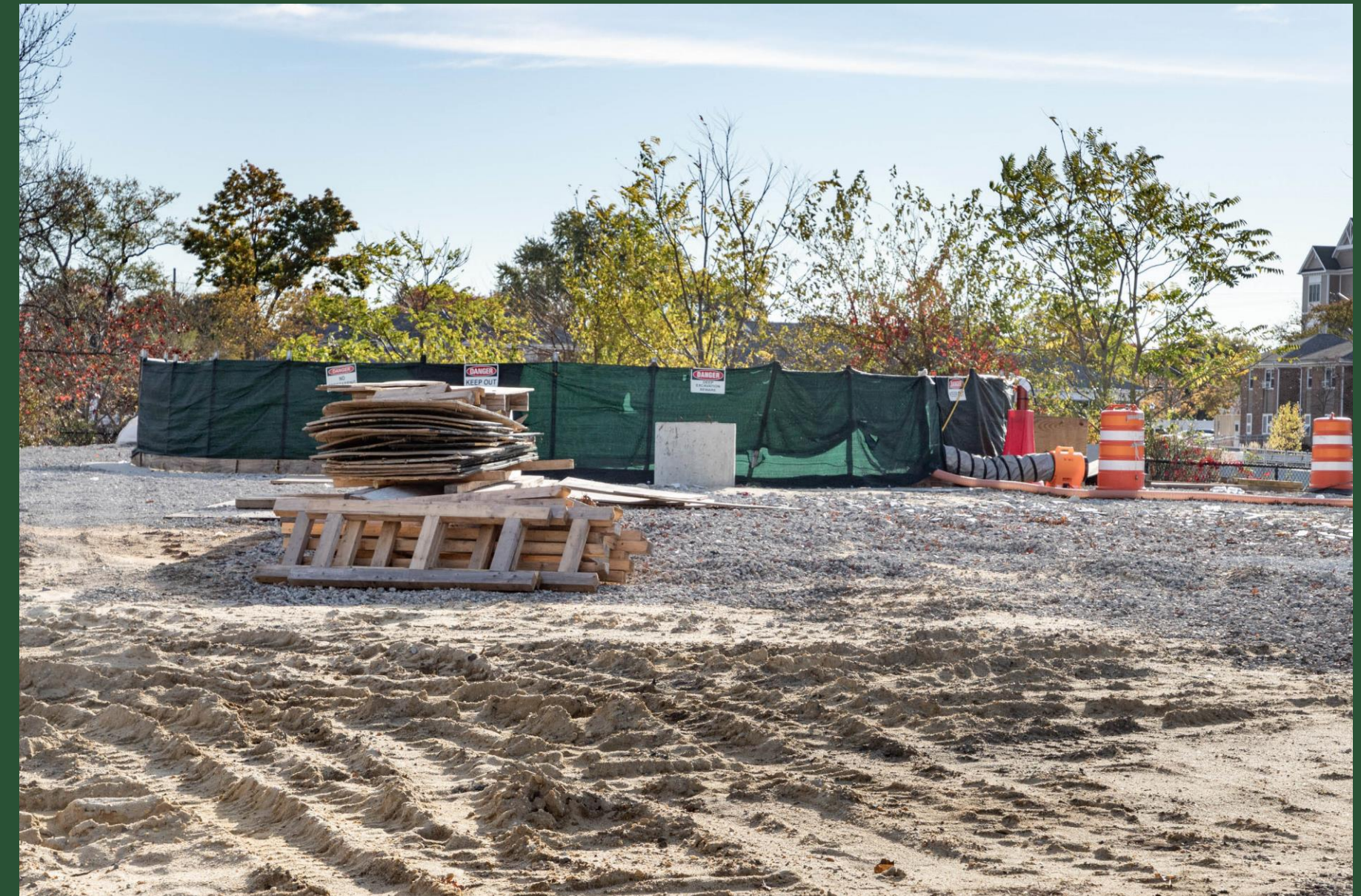
BP5 Construction Site (October 2022)
