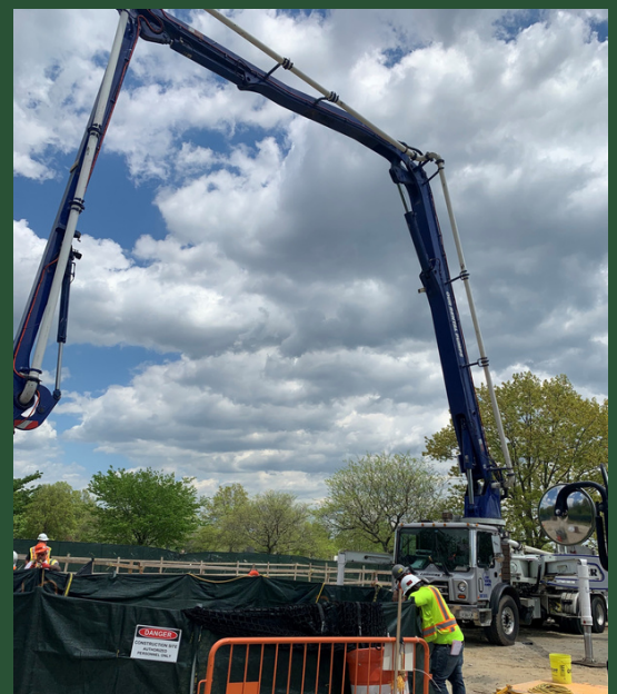
Concrete Pour at CC3 (May 2022)
