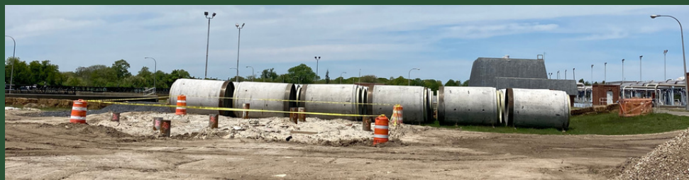
Mini Piles at CC1 (May 2022)
