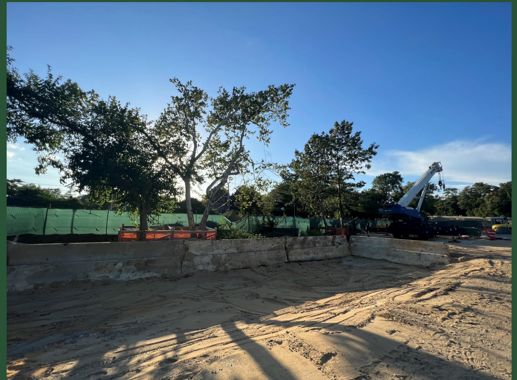
Construction Site at CC4 (August 2022)
