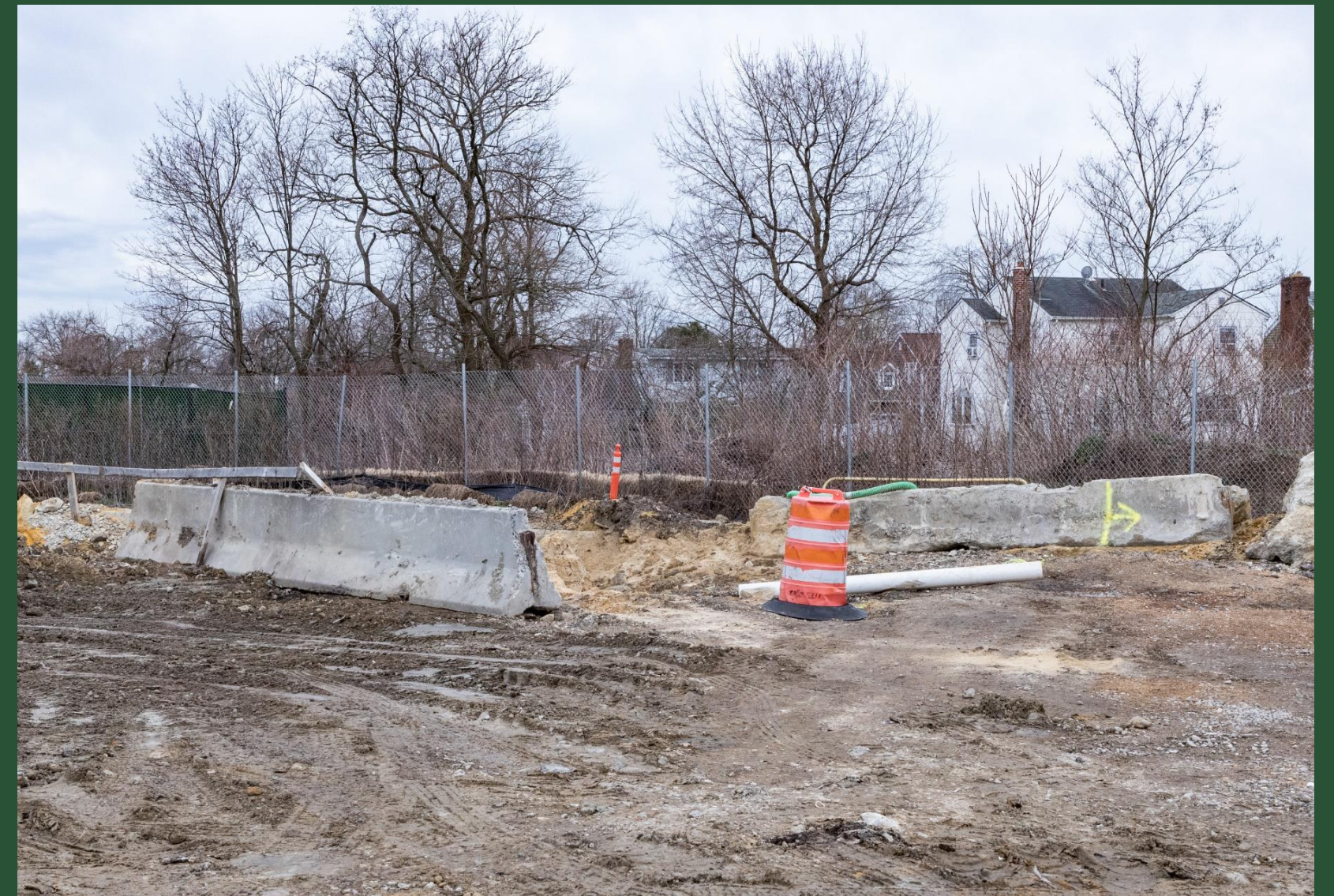
BP7 Construction Site (March 2023)
