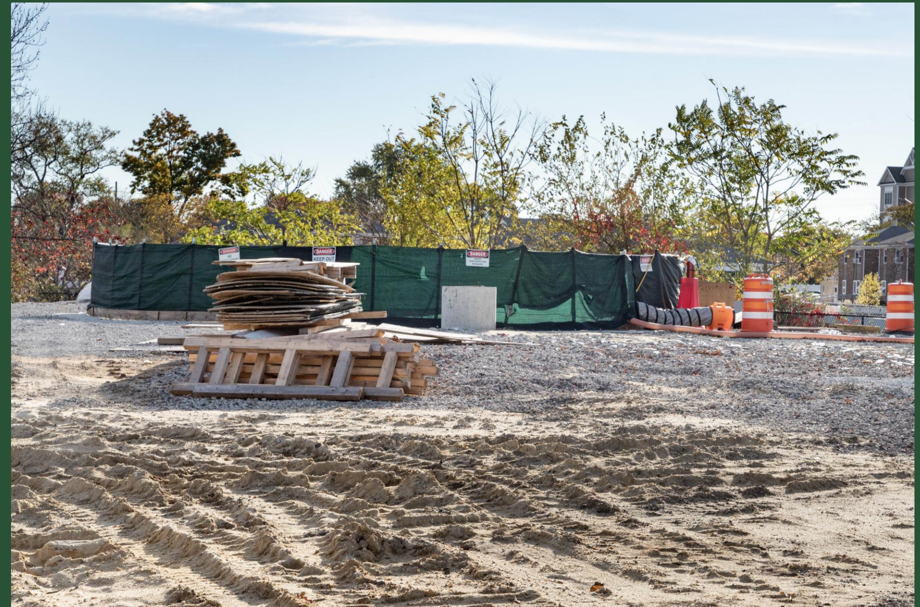
BP5 Construction Site (October 2022)
