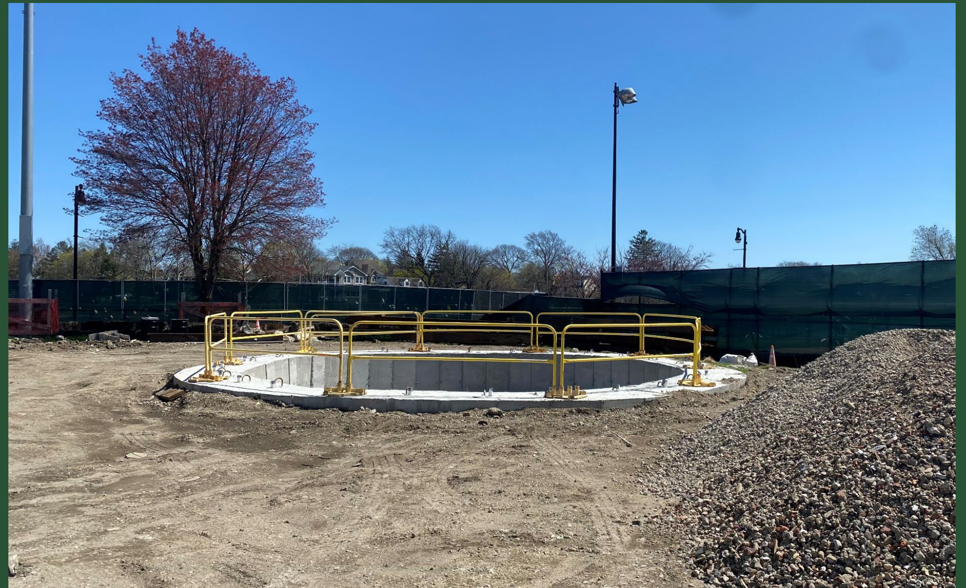
BP8 shaft site (April 2022)
