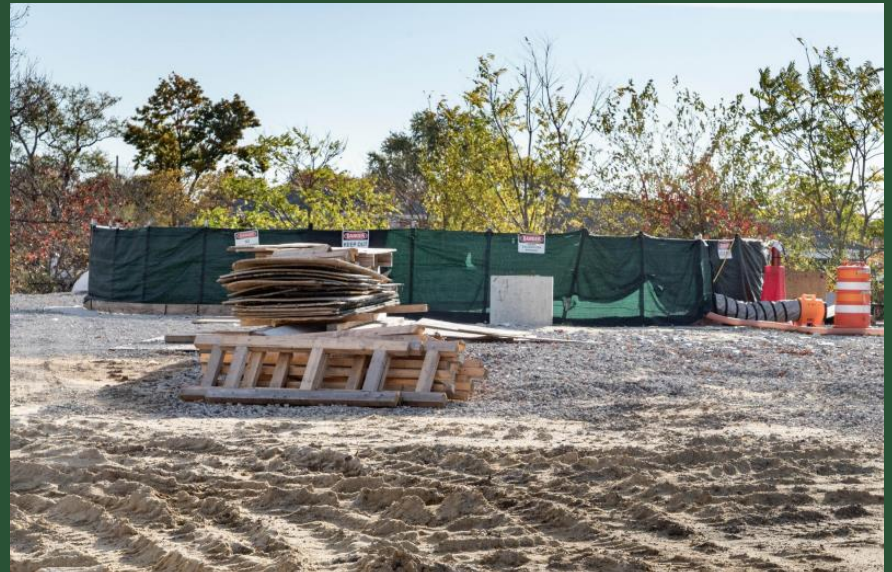
BP5 Construction Site (October 2022)
